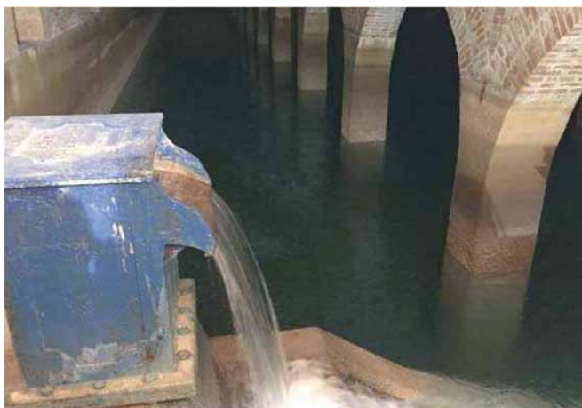
El depósito de agua de Tempul. VIVA
